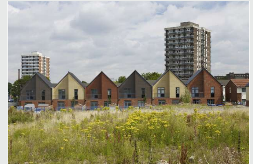
Fig. 4.1.3 New Islington, Manchester
